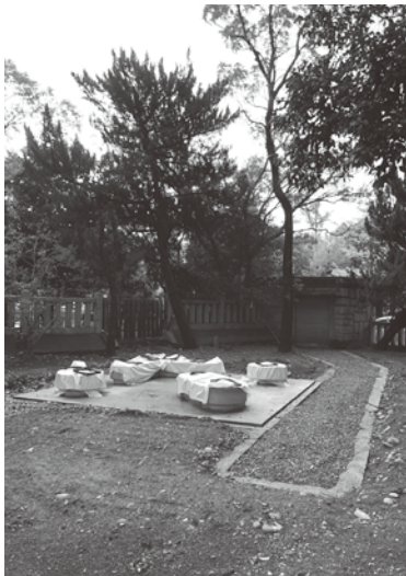
建設中の東屋（手前）・休憩所（奥）
